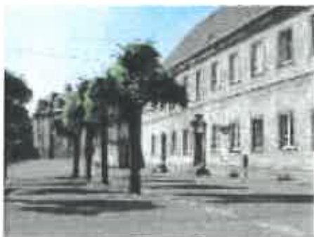
Le vieux bâtiment
